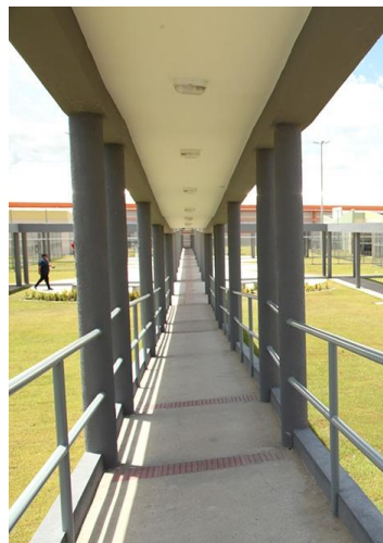
Fotografia 2 – Corredor de acesso às casas
